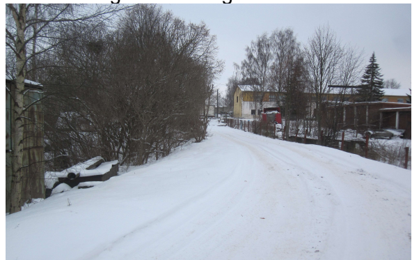
Foto 4. Krundi põhjapiiri ääres kulgev tõstetud kõrge teetammiga tee
